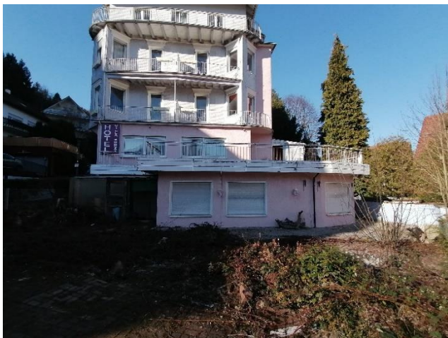
Blick vom Bernsteinweg auf das ehemalige Hotel
