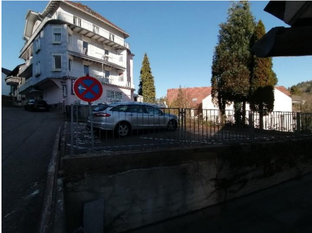
Blick vom Bernsteinweg auf das Vorhabengebiet
